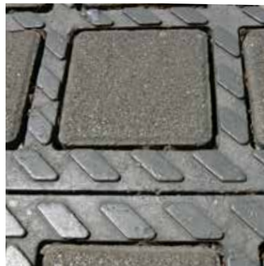
Noppung einer TTE® Platte nach 4 Jahren höchster Belastungen am Sendlinger Tor, München.
