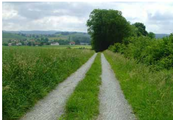
TTE®-Feldweg: die dauerhafte Bewehrung ohne Unterbau
